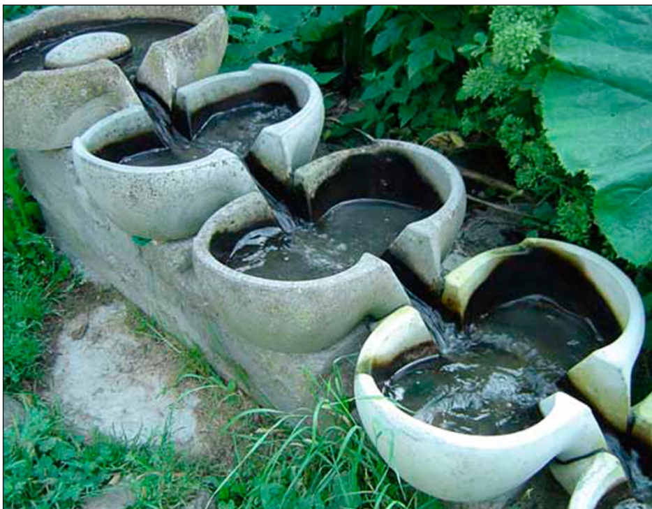
Järna vattentrappa med inloppsdel.
