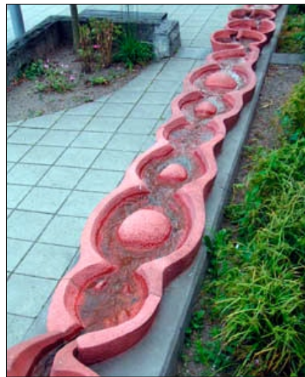
Två stycken Herten L11 Krokodil monterade efter varandra.
